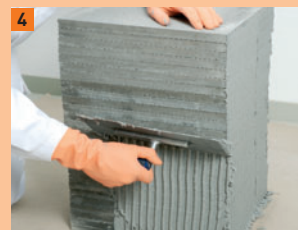
4 De lijm wordt alleen op de zijkanten van de gestapelde vloerelementen aangebracht.
