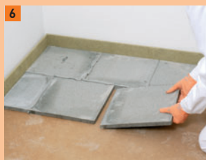
6 De Powerpanel SE vloerelementen worden in halfsteens verband gelegd, zodat vrijwel geen snijverlies optreedt.
