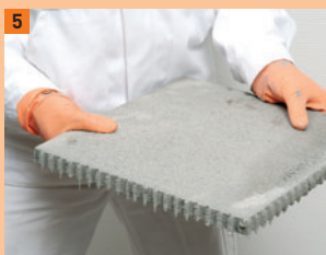
5 Met een getande lijmkam (6 mm) wordt de lijm aan twee kanten van de gestapelde platen aangebracht.
