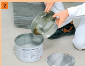
2 De twee componenten van de lijm worden samengevoegd...
