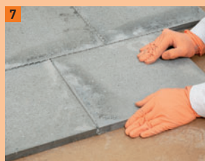
7 De platen worden stotend tegen elkaar geschoven (voegbreedte 1 - 1,5 mm).
