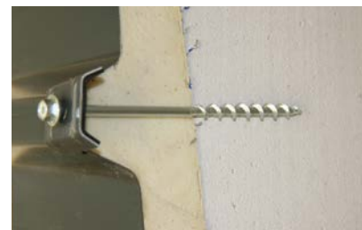
Sandwich paneel met zichtbare bevestiging
