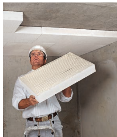
Het lijmen aan bestaande plafonds gebeurt in een handomdraai.
