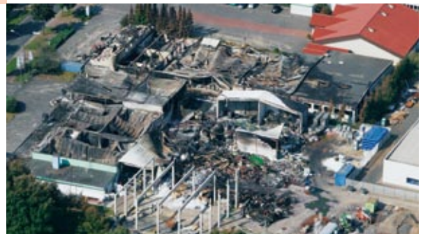
Een indrukwekkend voorbeeld van de eigenschappen van cellenbeton wordt geleverd bij de brand die op 31 augustus 2005 uitbrak in een verffabriek in Duitsland. Een technisch mankement in een opslagplaats voor verf, beitsproducten en reservoirs met chemische producten vormde de aanleiding van een brand die zich niet alleen verspreide naar de productiegebouwen van de verffabriek maar tevens oversloeg naar een aanpalende textielabriek. Het bluswerk werd vertraagd door de explosie van verschillende tanks met chemicaliën en werd bovendien extra bemoeilijkt door rondvliegende wrakstukken en de hevige rookontwikkeling. Resultaat: de opslagplaats ging volledig in de vlammen op en de productiehal van de verf-fabriek lag nagenoeg helemaal in puin. Enkel de opslagplaats voor gevaarlijke producten en de muren van het administratiegebouw bleven overeind. Beide waren opgetrokken uit cellenbeton.
